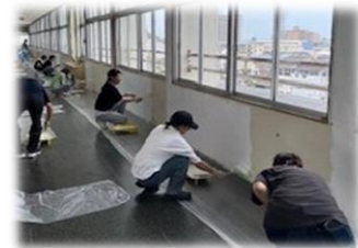
PTA 施設運営委員会ペンキ塗り
